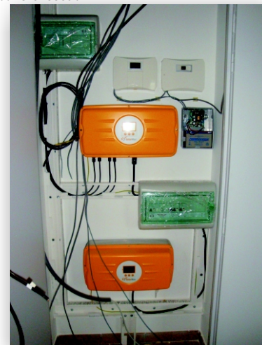
Les onduleurs transforment le courant produit par les panneaux photovoltaïques avant de l'injecter dans le réseau EDF.
