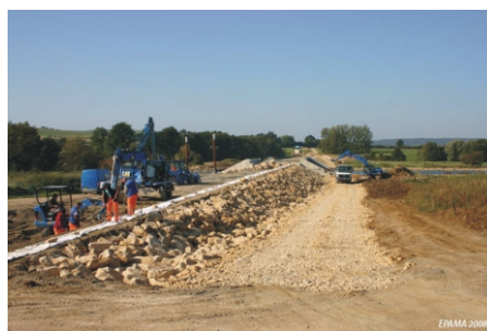
26/09/2008 : Vue sur les enrochements en aval de la digue
