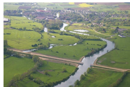
8 millions d'euros de travaux (Photo : source ONEMA)
